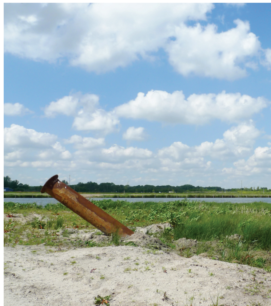
In Nederland ligt jaarlijks ruim 40.000 hectare grond braak, die door overheden of projectontwikkelaars is aangekocht voor woningbouw, infrastructuur, bedrijventerreinen of ontgroning.
